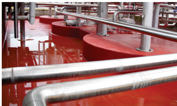
Афинажный завод Sika® Ucrete® MF Площадь 1000 м 2
