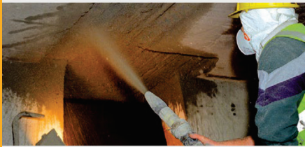
Ремонт и защита бетона
