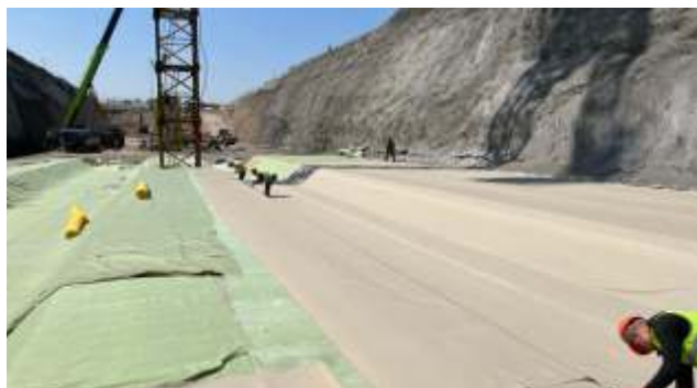
Станция метро "Калкаман" Площадь - 4 000 м 2 Алматы, Казахстан
