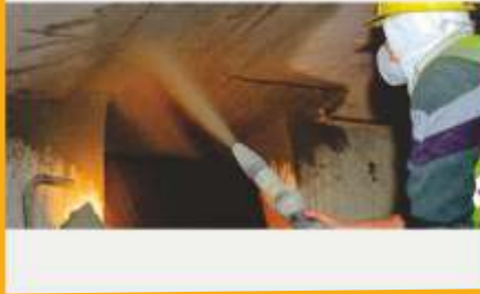
Ремонт и защита бетона
