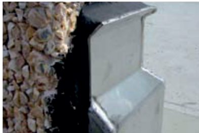
Кровельные стыковые соединения
