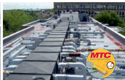
Ремонт кровли с помощью жидких мембран
