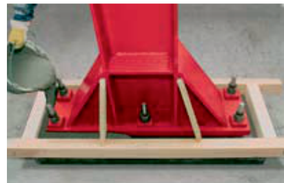
Заливка цементного раствора
