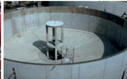
Швы водоочистительных сооружений
