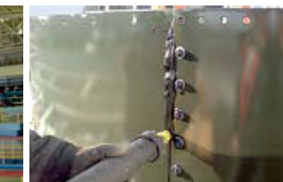
Герметизация и заделка швов
