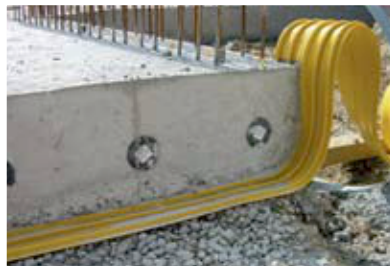
Гидроизоляция швов в конструкциях
