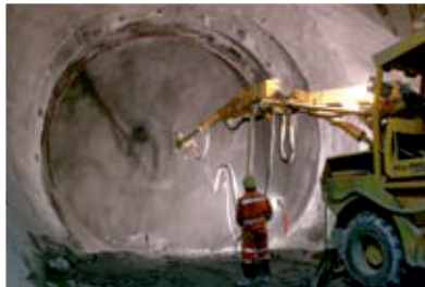
Нанесение торкрет-бетона
