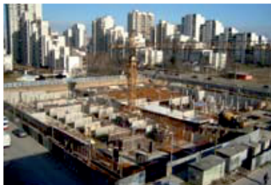
Производство на стройплощадке
