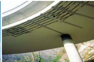
Опоры трубопроводных трасс
