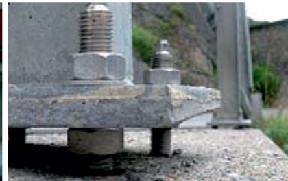
Закрепление; соединение резьбовых и арматурных стержней
