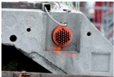
Цементация пучков из арматурных канатов
