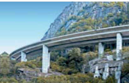
Ремонт, защита и усиление бетона
