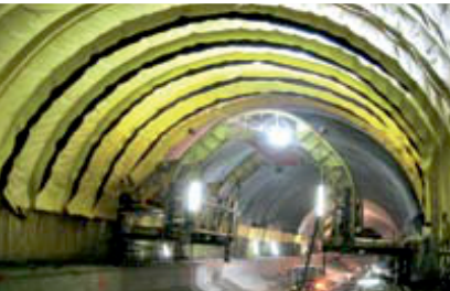
Гидроизоляция тоннелей
