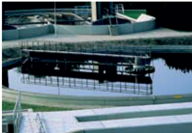
Технические резервуары спец. назначения
