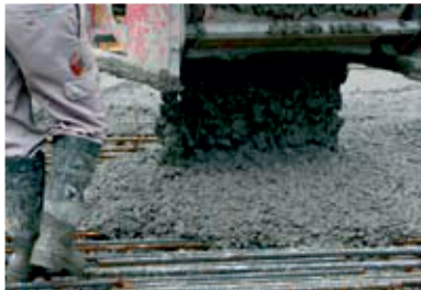
Применение специального бетона
