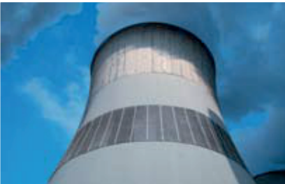
Дымовые трубы и градирни
