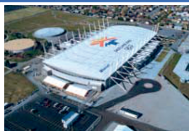
Нанесение логотипа на кровлю
