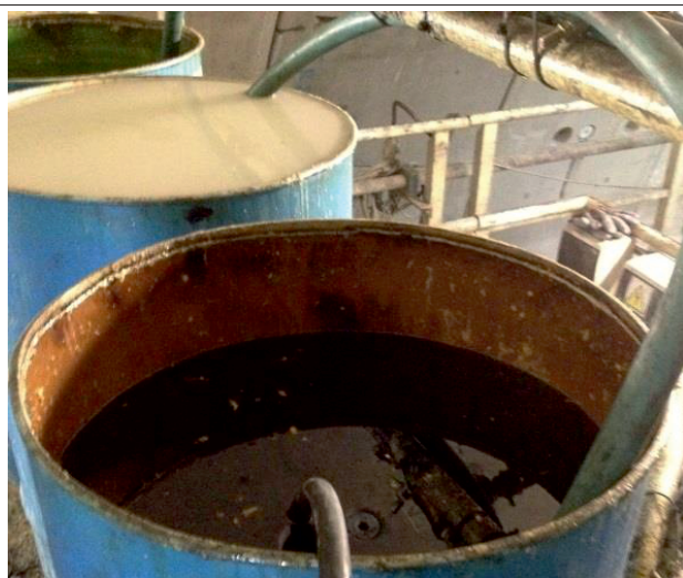
Бочки со смешанным материалом для инъектирования смолы (комп.А+)
