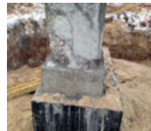
Дефекты бетонирования
