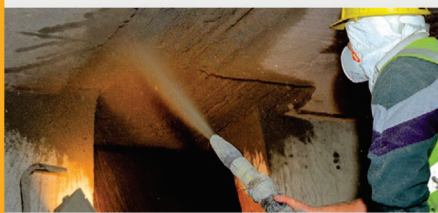
Ремонт и защита бетона
