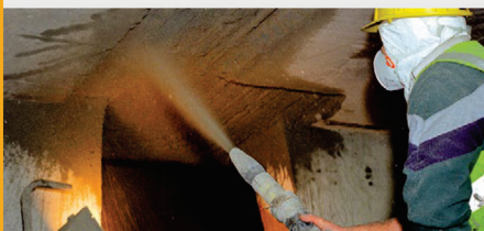
Ремонт и защита бетона
